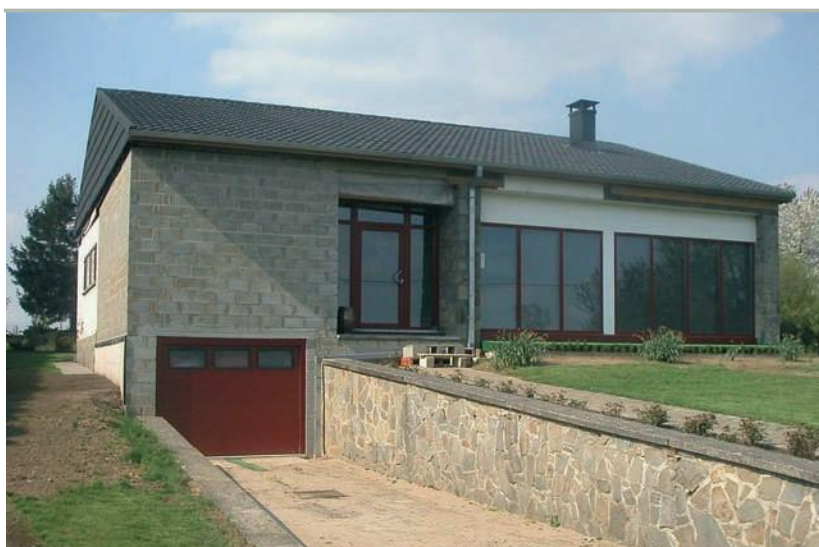
Rodinný dům před sanací fasády
