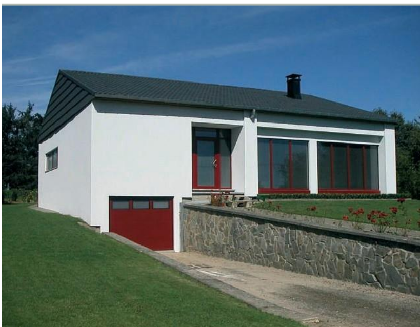
Rodinný dům po sanaci fasády systémem vinyTherm
